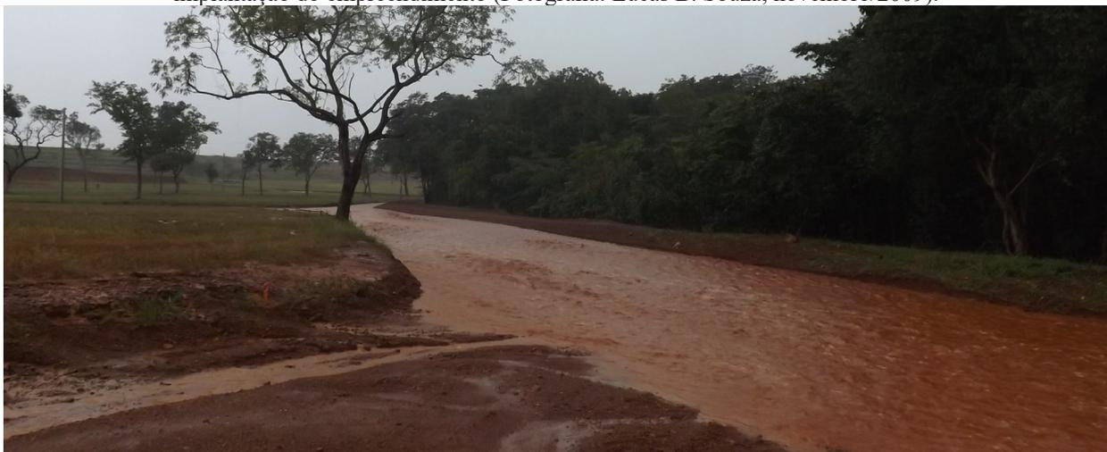
Figura 12 - Enxurrada, transporte de sedimentos e acúmulo de água pluvial em via do loteamento Jardim Nova América (Fotografia: Lucas B. Souza, março/2015).
