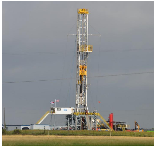
Figura 7 - Infraestrutura para a perfuração de poço no Eagle Ford.
