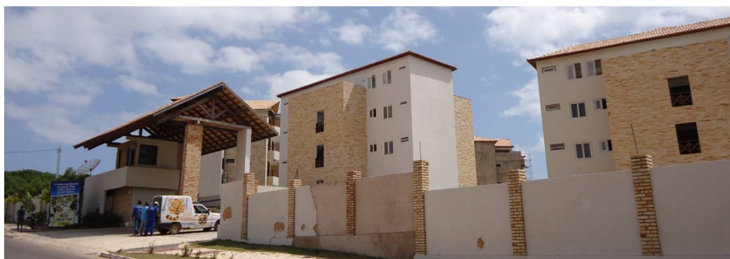
Figura 3 - Condomínio vertical em Tibau-RN Autora: Iara Rafaela Gomes
