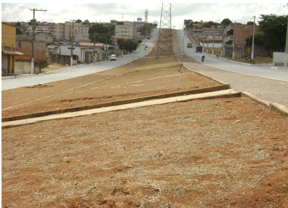
Figura 1 - Área da linha de distribuição de energia elétrica preparada para instalação de horta comunitária no bairro Felipe Cláudio em Pedro Leopoldo- MG
