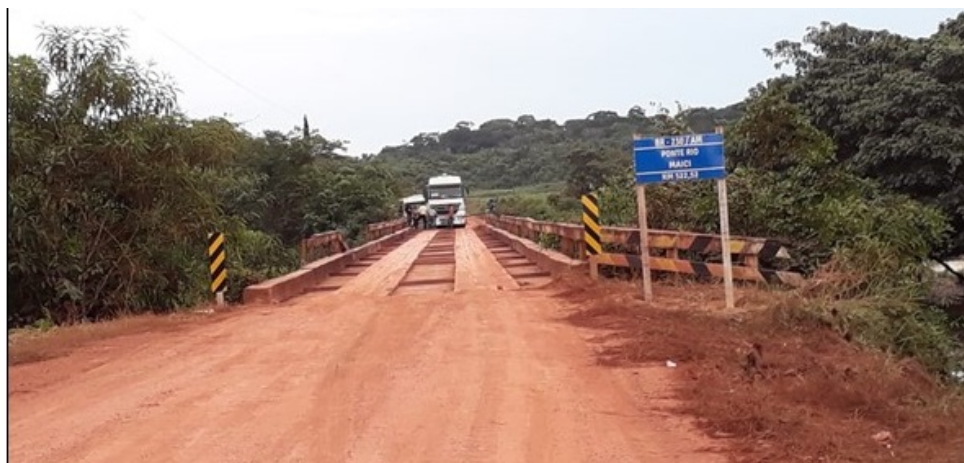
Figura 1 – Trecho da Rodovia Transamazônica – BR230, sul do Amazonas. Fonte: ARAÚJO, 2017.
