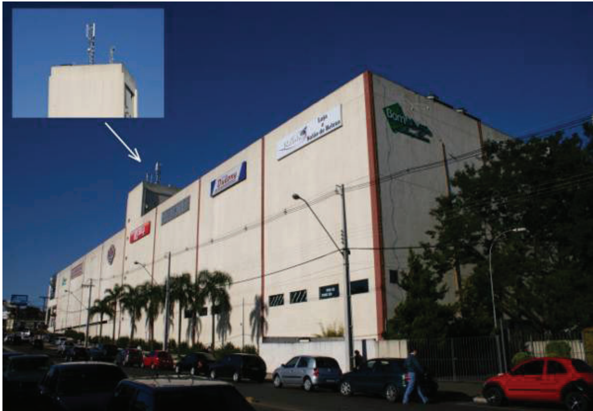
Figura 8 - Sobreposição de uma ERB sobre a caixa de água de um shopping center
